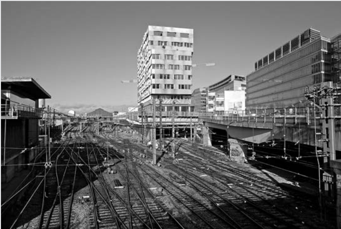
FIGURE 3.1 / Projet Paris Rive Gauche - Secteur Austerlitz - Les voies ferrées sont pour l'instant partiellement couvertes et accueillent en surface une avenue et un immeuble en construction
