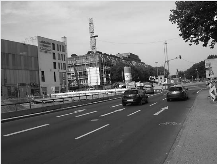
FIGURE 3.3 / Projet de la Kombilösung - La voie rapide de la Kriegstraße avant sa couverture
